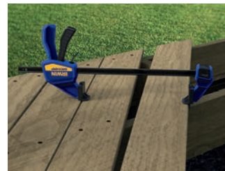
Κατασκευή δαπέδου/ καταστρώματος
